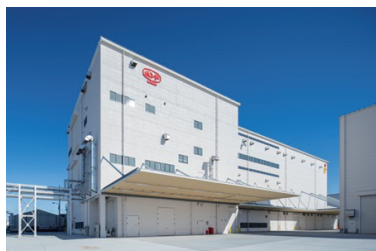
コニシ(株) 栃木工場水性接着剤製造所・物流倉庫
