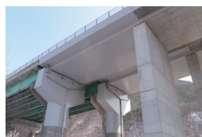
コンクリートはく落防止
