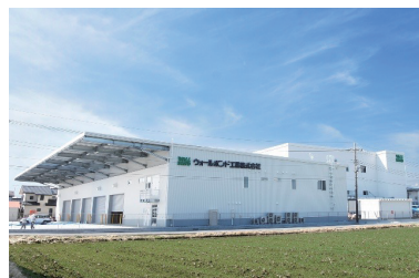
ウォールボンド工業(株) 物流倉庫
