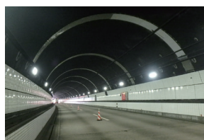
トンネル改修
